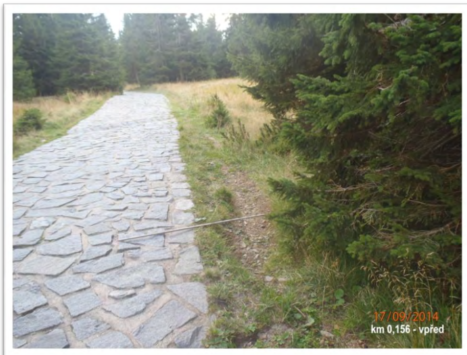
Obr.1.: Poškozený terén od stékající vody v km 0,156
